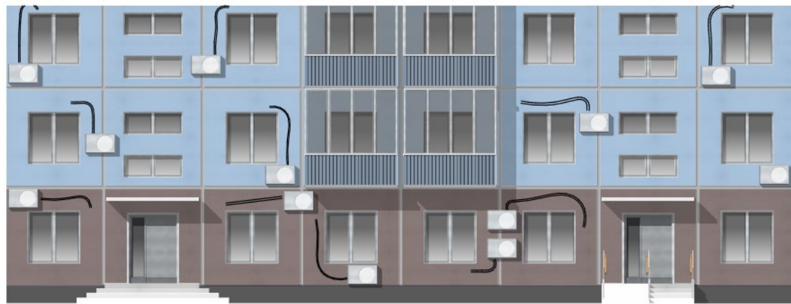
Не рекомендуется. Кондиционеры на фасаде расположены хаотично, провода проложены неоптимально — это создает визуальный шум
